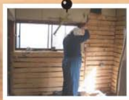
解体工事 古い設備機器を解体します。
