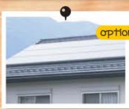
太陽光発電 電気代の大幅節約+余った電力を売電することができるので、家計にも地球にも優しいプラン。
