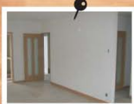
全室クロス張替え トイレ・洗面所・玄関ホール・2Fなど家中のクロスを貼り替えます。
