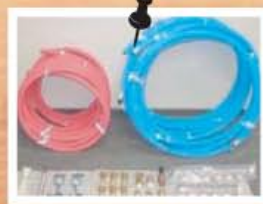
水道工事 宅内の古い配管を取り替えます。
