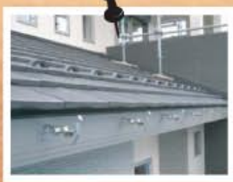
樋掛け替え 傷んだ樋を放置しておくとうもろこし雨漏りの原因になったり、家の寿命を早めるおそれがあります。
