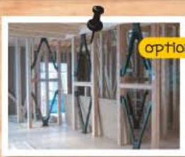
耐震補強 リフォーム工事時に耐震工事を同時進行。※耐震診断に基づき補強工事を行います。
